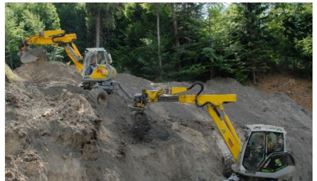
Abbildung 3: Enorme Materiallogistik und Bedarf von zwei Schreitbaggern
