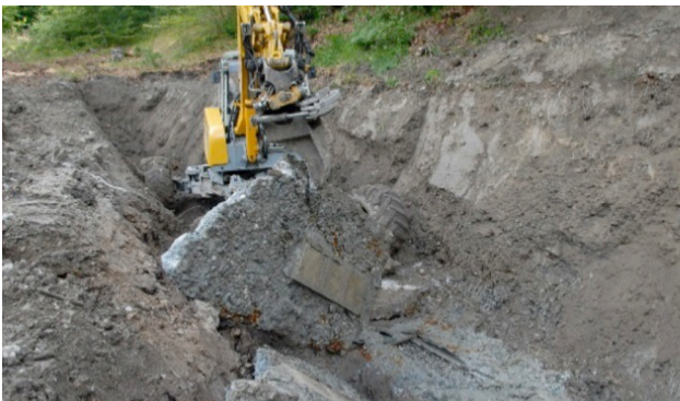
Abbildung 2: Abbruch der ca. 70 Jahre alten Quelfassung
