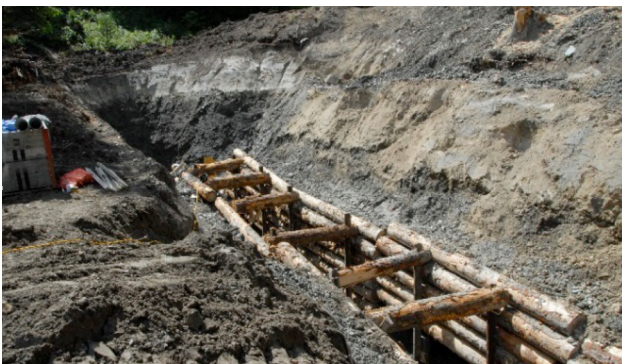
Abbildung 4: Spriessung des Grabens mit Baumstämmen und Eisenbahnschienen
