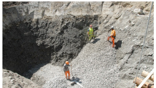
Abbildung 5: Erste Etappe der Quelfassung, hier Einbringung von Geröll
