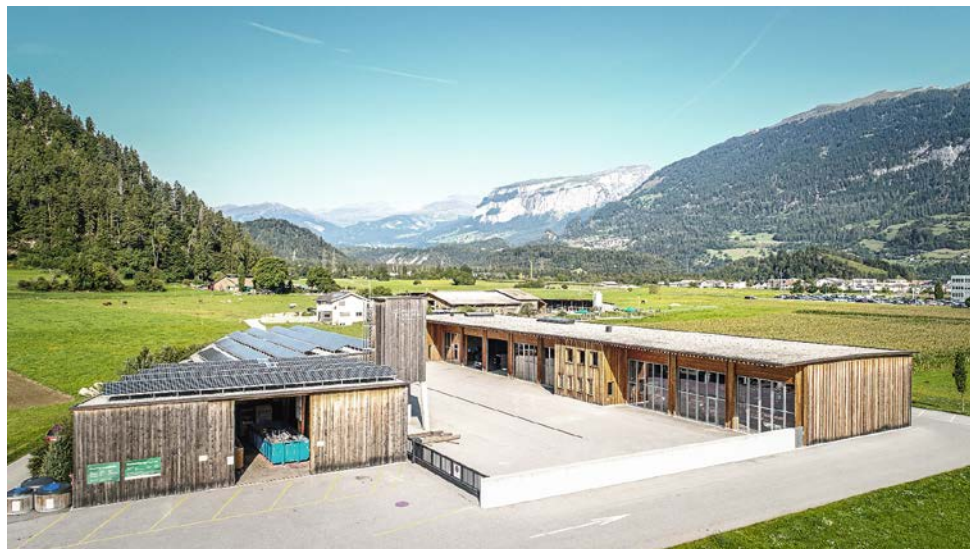
Standort Gemeindebetriebe Bonaduz Rhäzüns mit Erdsonde-Wärmepumpe und Photovoltaikanlage, Quelle: Bildsammlung Gemeinde Bonaduz
