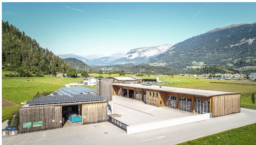
Standort Gemeindebetriebe Bonaduz Rhäzüns mit Erdsonde-Wärmepumpe und Photovoltaikanlage, Quelle: Bildsammlung Gemeinde Bonaduz
