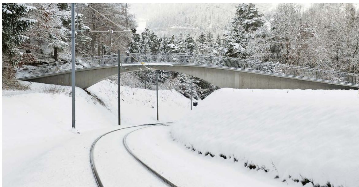
Gurgs-Brücke in Bonaduz, auch kleine Objekte achtsam gebaut
