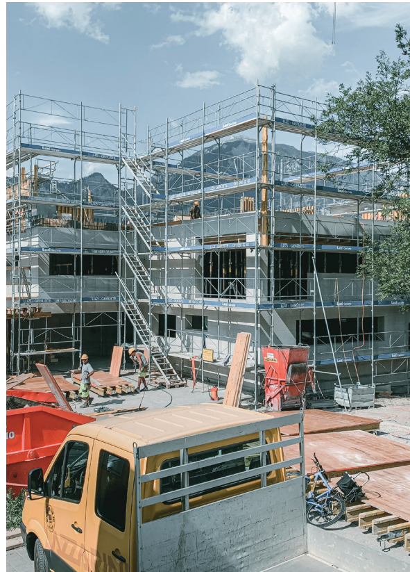
im Oktober wird der Rohbau abgeschlossen
