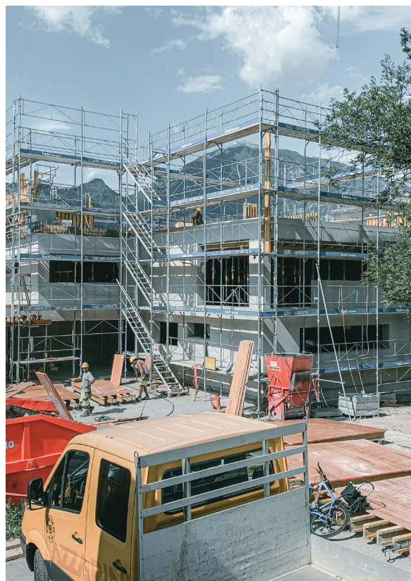
im Oktober wird der Rohbau abgeschlossen
