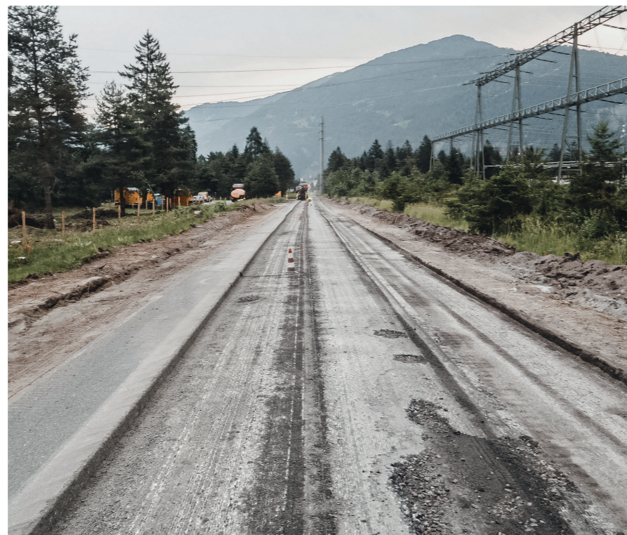
Die letzte Bauetappe der Oberländerstrasse wird im 2021 abgeschlossen.
